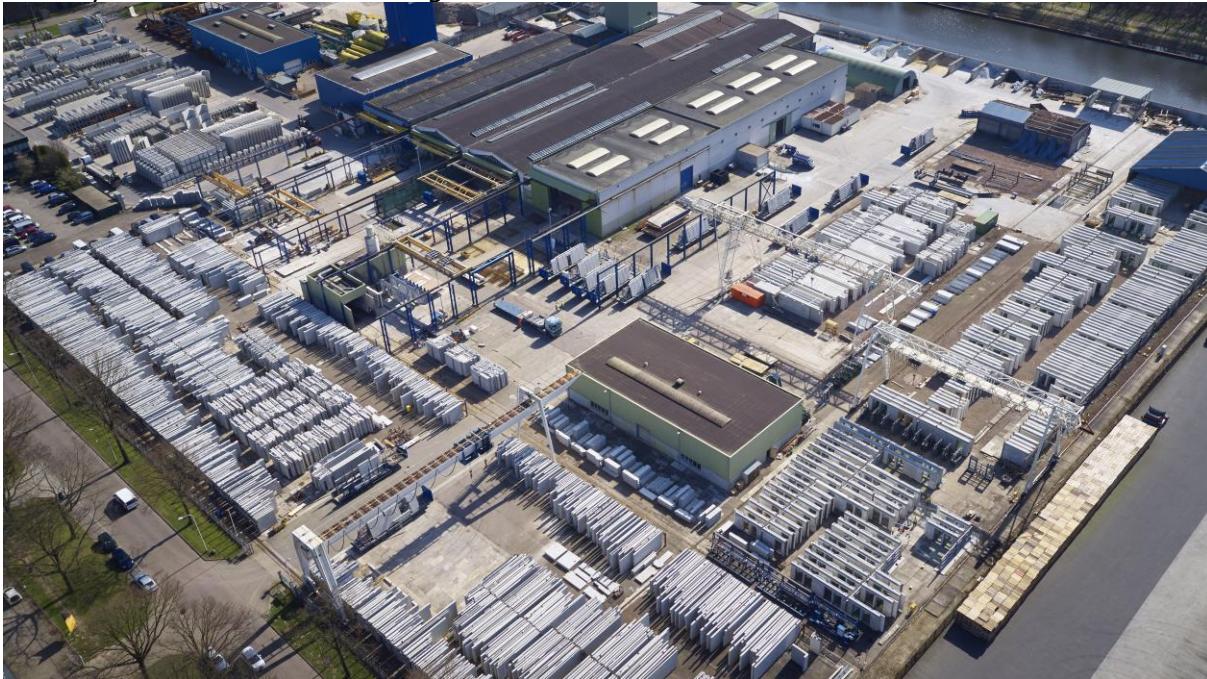
Foto Byldis Prefab locatie Tilburg
